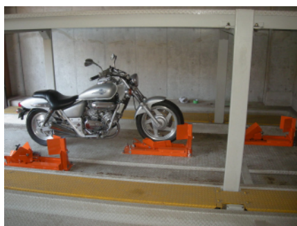
東京都江戸川区 地下ピット単純昇降式
